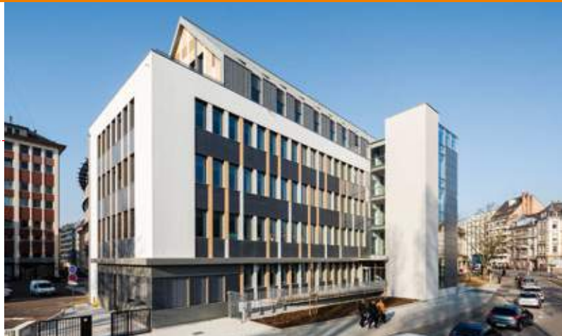
↓ Parking des H.U.S. à Hautepierre, Nogha Consulting, 2015
