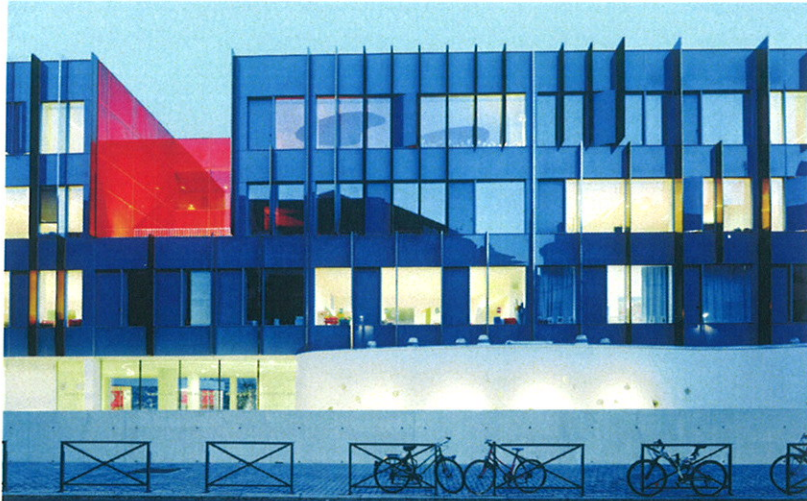
60년대 지어진 건물을 리모델링한 Groupe Scolaire Saint Jean.
