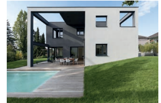
Maison « aux carrées » – 67370 TRUCHTERSHEIM
