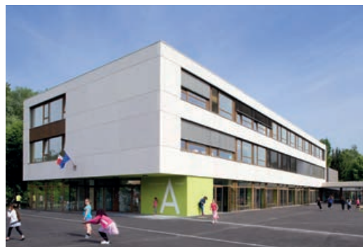
Restructuration et extension du groupe scolaire Ampère, Neudorf – 67100 STRASBOURG
