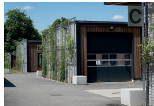
Locaux techniques du cimetière central 68100 MULHOUSE
