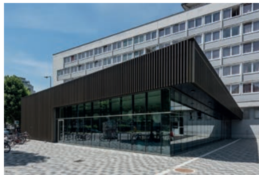
Construction du nouveau restaurant universitaire Paul Appel – 67000 STRASBOURG
