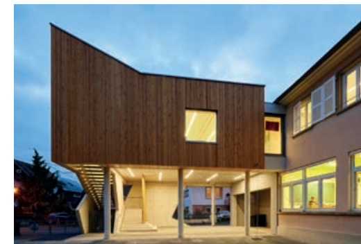
Réhabilitation d'anciens logements pour l'accueil périscolaire – 67850 OFFENDORF
