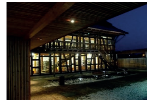
Construction reconstruction et extension de la bibliothèque – 67114 ESCHAU
