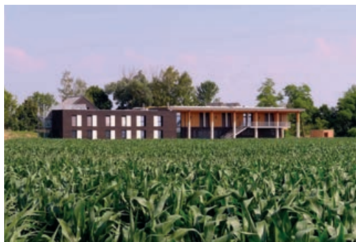
Extension et restructuration de la maison éclusière 68140 HIRTFELDEN
