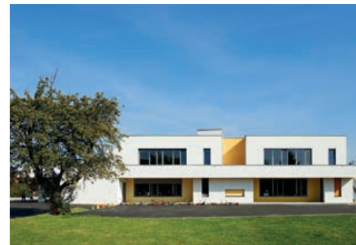
Construction du nouveau groupe scolaire Jules Verne – 67207 NIEDERHAUSBERGEN
