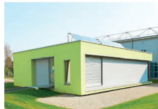
Construction d'un bâtiment associatif, centre sportif de la Robertsau – 67000 STRASBOURG
