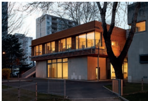
Extension et mise en sécurité de l'école maternelle Robert Schumann – 67000 STRASBOURG
