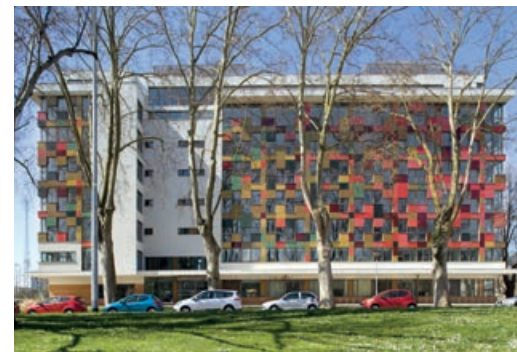
Construction du siège du Pôle de l'habitat social 67000 STRASBOURG
