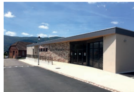
Construction d'un accueil de loisirs sans hébergement (ALSH) – 68770 OSENBACH
