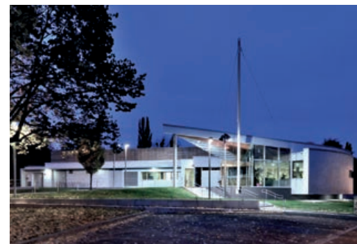
Extension et restructuration de la piscine – 67540 OSTWALD
