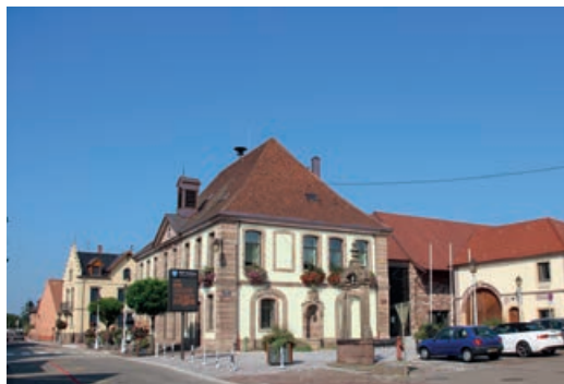
Restructuration d'un ancien corps de ferme en mairie et pôle culturel – 68127 SAINTE-CROIX-EN-PLAINE
