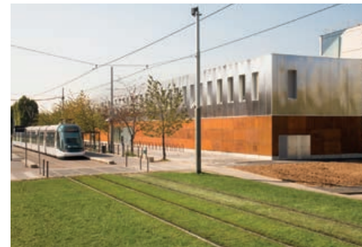
Construction de la pépinière d'entreprises, Hautepierre 67000 STRASBOURG
