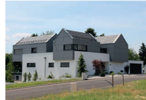
Construction d'une maison individuelle 68730 RANSBACH-LE-BAS
