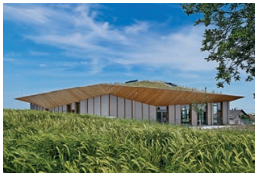
Construction d'une salle plurifonctionnelle 67440 REUTENBOURG
