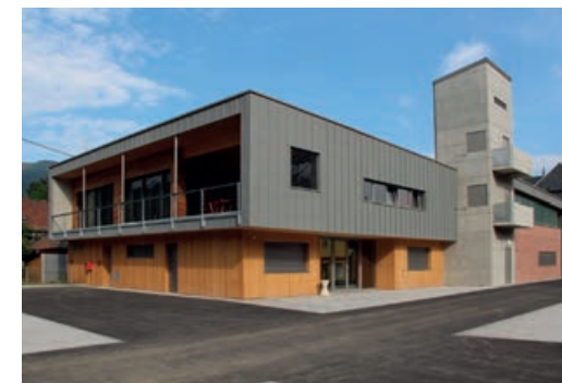
Construction d'un centre de première intervention 68680 BITSCHWILLER-LES-THANN
