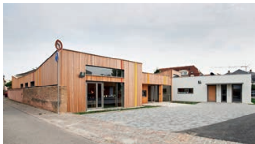
Extension de l'école maternelle et construction de l'accueil périscolaire – 67500 HAGUENAU
