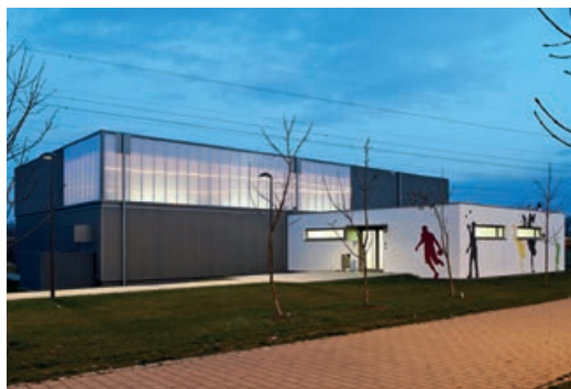
Construction du gymnase « Sporty » des Hirondelles
