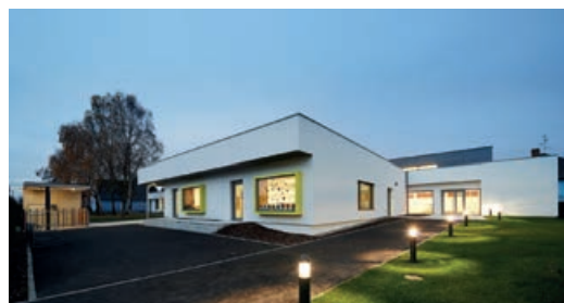
Rénovation et extension de l'école maternelle 67230 HUTTENHEIM
