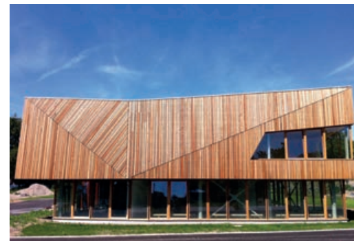
Construction d'un nouveau club d'aviron pour le Rowing club – 67000 STRASBOURG
