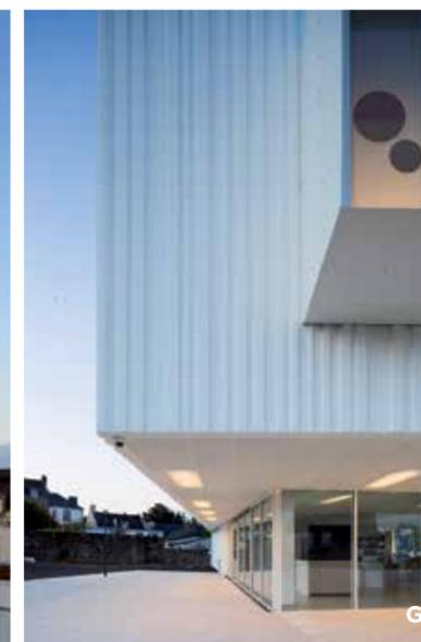
**G** Des cannelures verticales ont été réalisées à partir de matrices soigneusement dessinées par les architectes.
