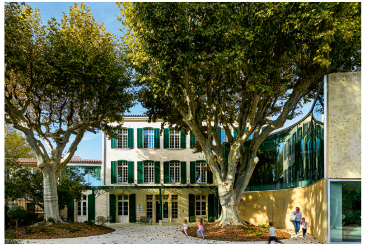
Mediathek in Pélissanne: Erweiterung des Bestands ... • Media library in Pélissanne: Extension of the existing ...
