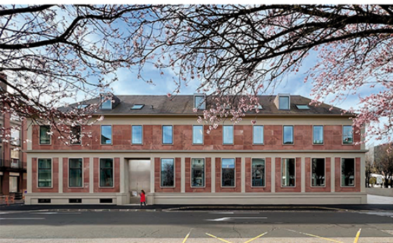
Vue sur la rue principale. Les interventions minimales en façade préservent la caractéristique patrimoniale du bâtiment et réduisent le coût du projet.
