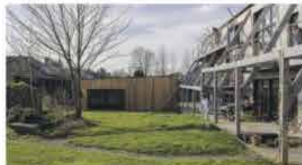
Cécile Gaudoin architecte Habitat groupé coopératif la pierre – Ile-et-Vienne photo © QLG
