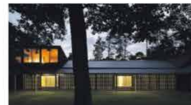
Boidot & Robin architectes Un toit en lièze – Yvelines photo © Clément Guillaume
