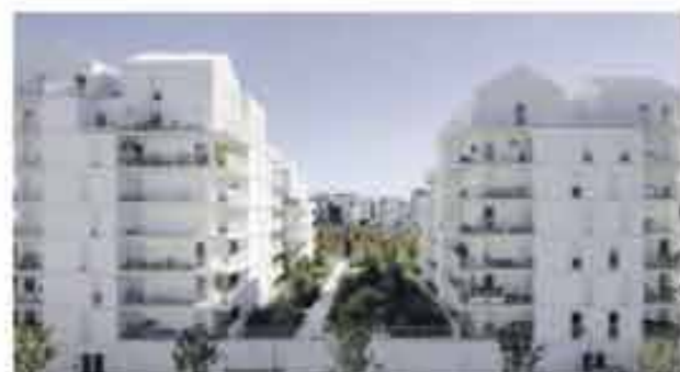
Marjan Hessamfar & Joe Vérons architectes associés 96 logements collectifs & intermédiaires – Gironde / photo © Jean-François Tremogé
