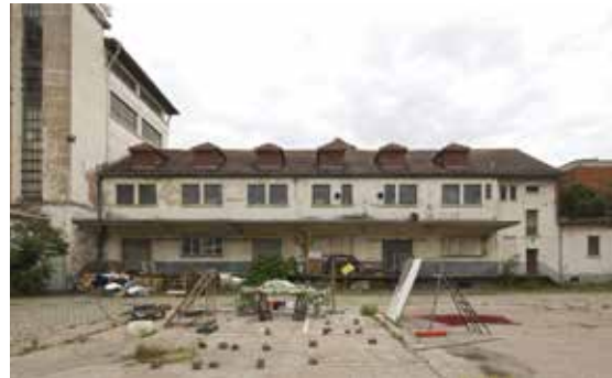
La Sérigraphie avant travaux © A. Duboys Fresney
