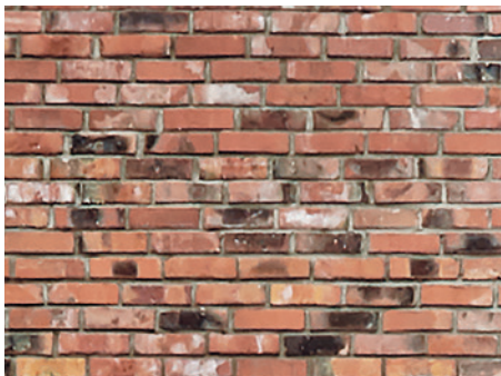
Läuferverband Running bond
