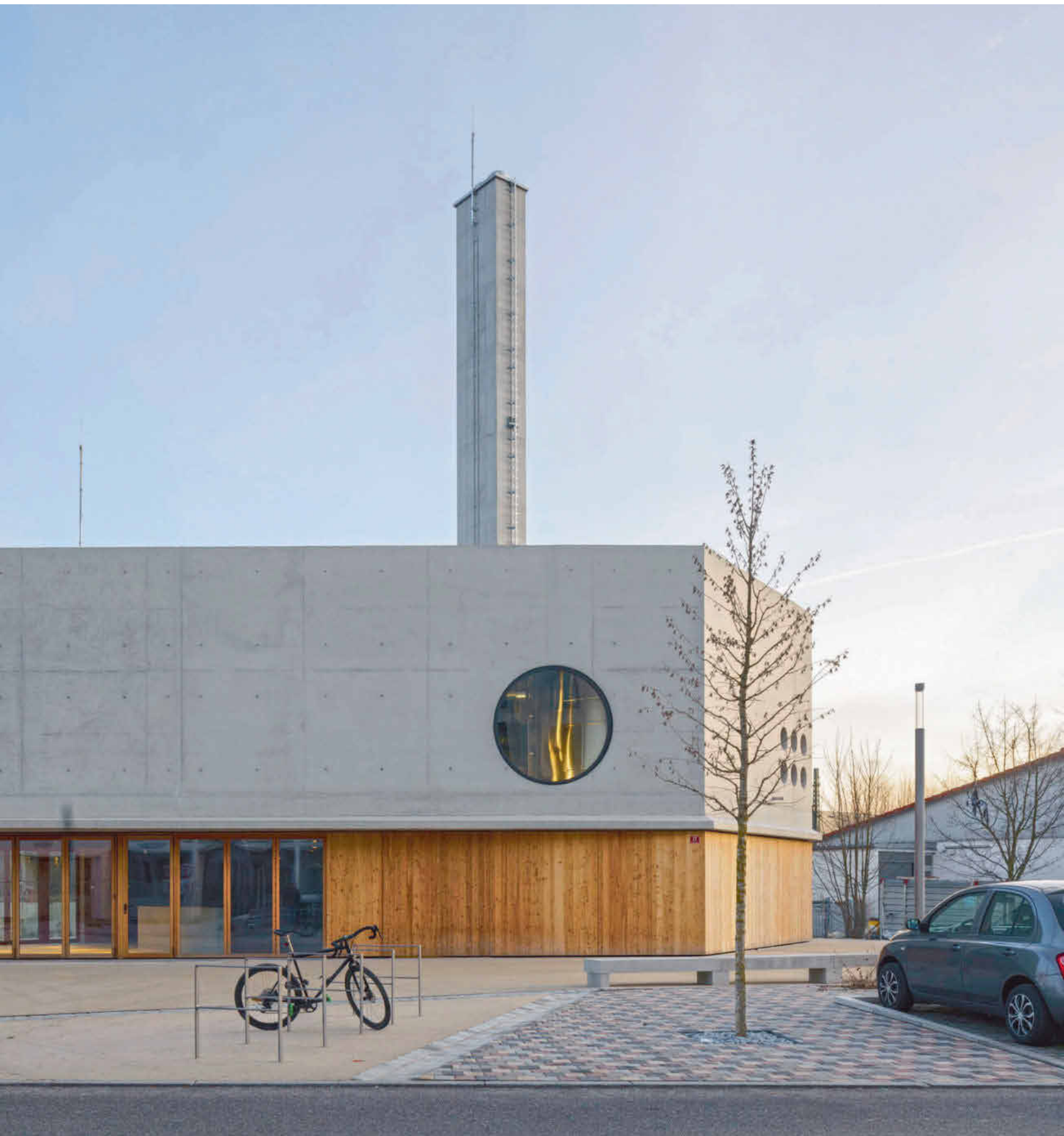
[1] Die Energiezentrale vereint die ungewöhnliche Kombination aus Café und Blockheizkraftwerk in einem Gebäude
