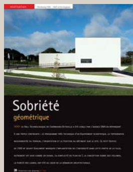
>> PAGE 28 > Cherbourg Hall technologique Architecte : Enia architectes
